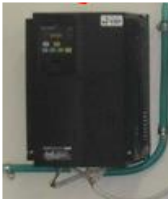
Figura 3.9 Regulador de frecuencia, 3G3RX-A4185 OMRON
