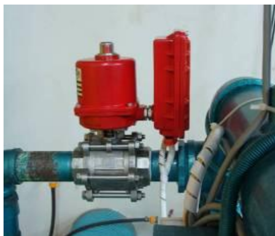
Figura 3.8 Válvula TRIAC Control Serie EMI-300E
