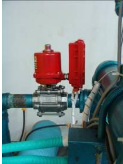
Figura 1: válvula para el control del caudal
