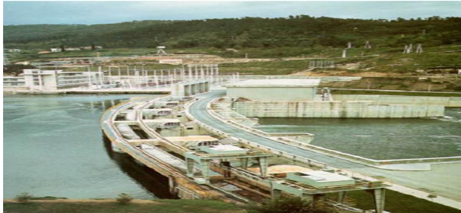
Figura 0-3. Central de agua afluyente. [6]
