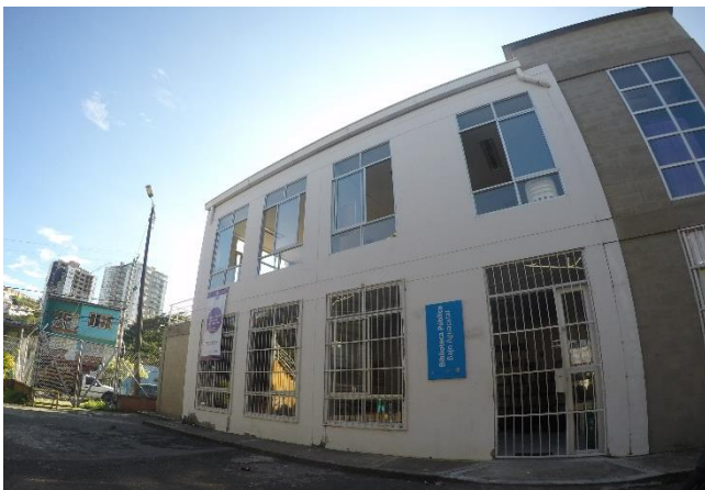
Ilustración 4. Fachada de la Biblioteca Bajo Aguacatal (nueva sede). Fuente: Fotografía tomada por Nathalia Cárdenas el 18 de mayo de 2017.
