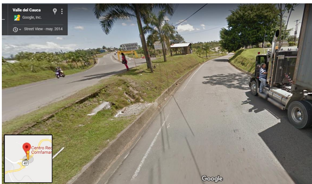
Figura 10. Final del tramo de la vía alterna-interna de Buenaventura
