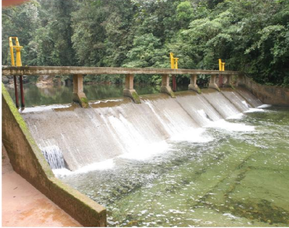
Foto N° 1: Bocatoma Acueducto de Buenaventura, río Escalerete
