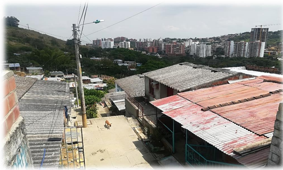
Foto 3: Urbanización La Fortuna, entrada a uno de los callejones que conforman el sector. Fotografía tomada en el año 2016.
