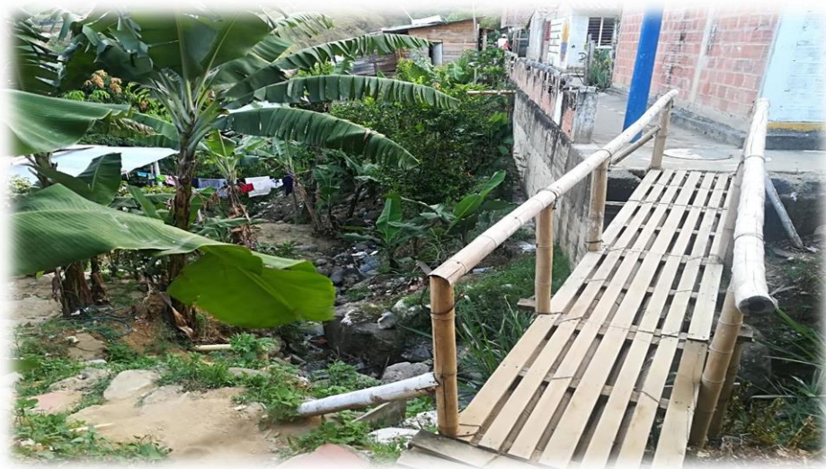
Foto 4: Puente interno que conecta la Urbanización con el barrio La Fortuna.
