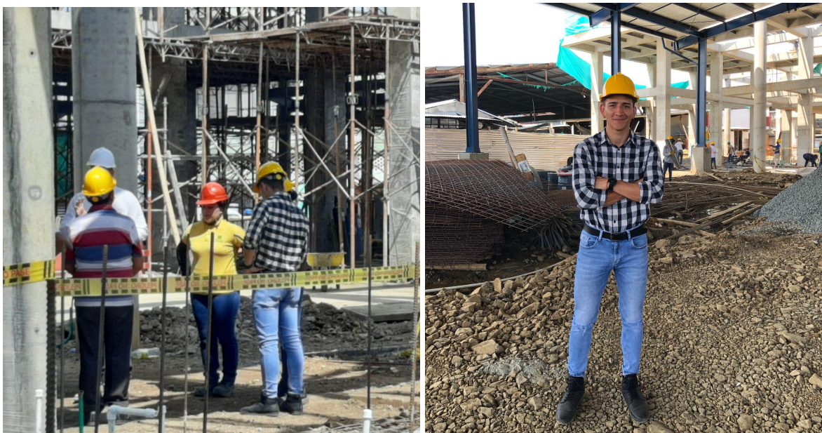
Figura 23. Recorrido por la obra de la plaza de mercado.
