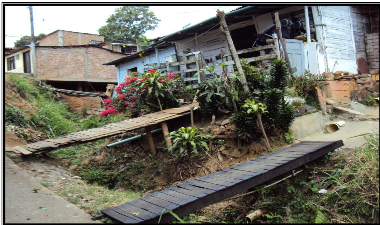
Fotografía N° 4. Actividades contaminantes en torno a la quebrada “Guarrús” en el barrio La Sultana.
