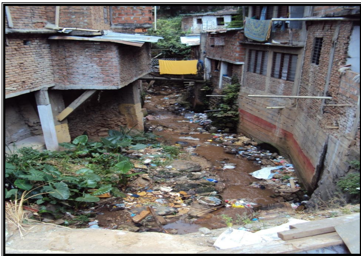
Fotografía N° 5. Viviendas cercanas a la quebrada “Guarrús” generando contaminación.
