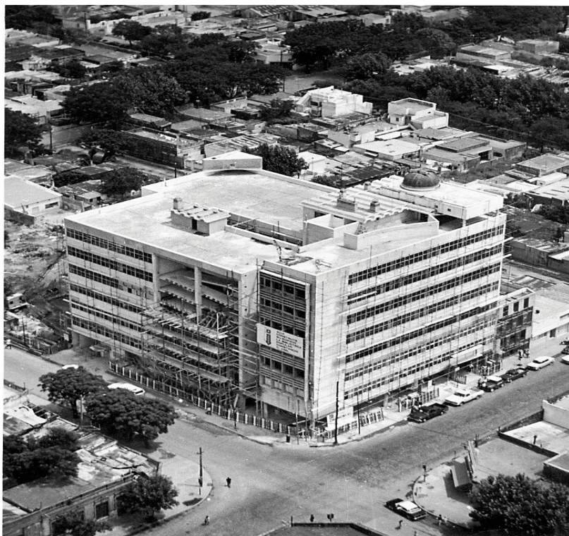
Figura 8. Principal inmueble en construcción 1969
