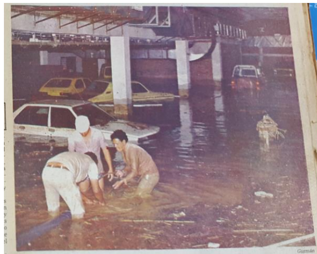
IMAGEN No. 43. INUNDADO EL CAM. “Serios daños al sistema eléctrico y telefónico del Centro Administrativo Municipal (CAM) ocasionó la creciente del Río Cali, ocurrida el domingo pasado. El edificio permanecerá cerrado hoy al público. Alrededor de 45 vehículos quedaron sumergidos, pues las aguas inundaron los sótanos y parqueaderos 283 .
