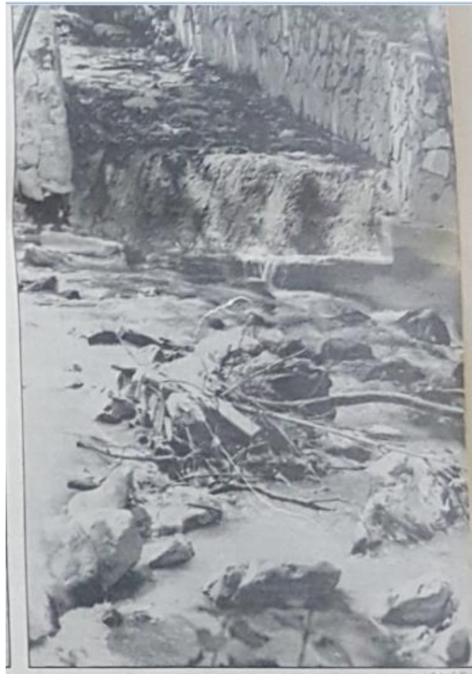
IMAGEN No. 36. VERTIMIENTO DE AGUAS NEGRAS. “En las ciudades se realizan millonarias inversiones para dotar de agua potable a la comunidad, pero se descuida la disposición final de las aguas negras y la mayoría son vertidas a los ríos sin tratamiento alguno. En el Valle los municipios intermedios comienzan a preocuparse de este problema” 226 .
