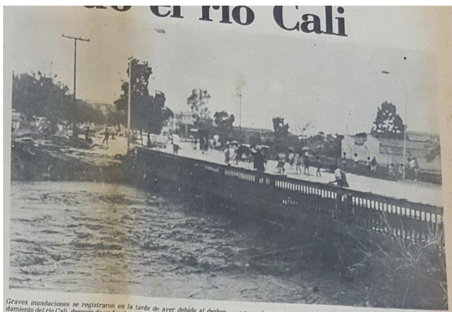
IMAGEN No. 40. GRAVES INUNDACIONES. Graves inundaciones se registraron en la tarde de ayer debido al desbordamiento del río Cali, después de un fuerte aguacero caído sobre la ciudad. Las aguas alcanzaron alturas superiores a los tres metros. Uno de los puentes afectados fue el de la calle 34, frente de la Ciudadela Bueno Madrid 280 .
