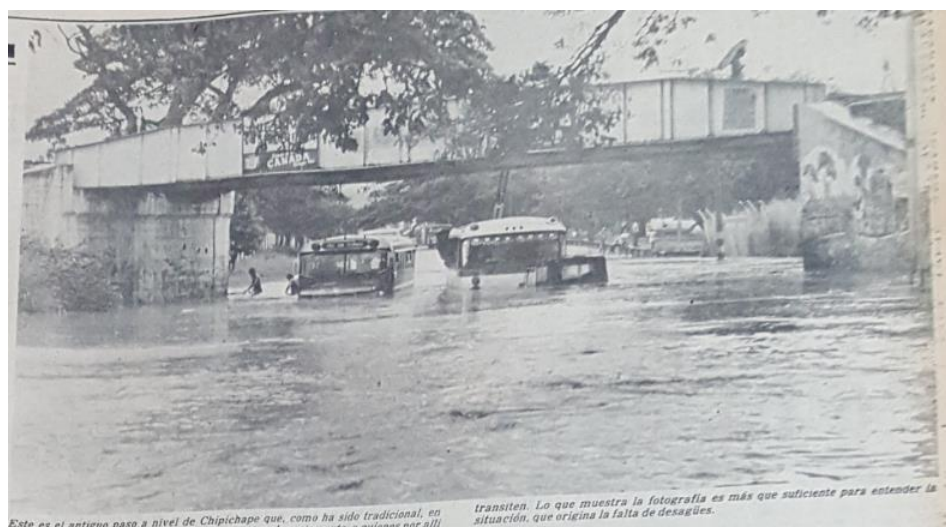
IMAGEN No. 38. PASO A NIVEL INUNDADO. Este es el antiguo paso a nivel que, como ha sido tradicional, en épocas de lluvia se convierte en un río, amenazando seriamente a quienes por allí transitan. Lo que muestra la fotografía es más que suficiente para entender la situación, que origina la falta de desagües. 276
