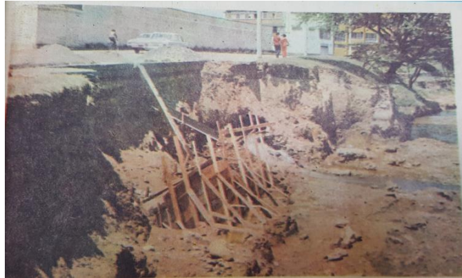
IMAGEN No. 29. EROSIÓN EN LA RIBERA DEL RÍO CALI. “La Erosión del Río Cali: El avance de la erosión en las orillas del Río Cali, ha obstaculizado notoriamente el levantamiento del muro de contención que viene construyéndose a lo largo de varios tramos de la vía aledaña al río. La gráfica corresponde al sector comprendido entre las calles 19 y 20, destruido por los derrumbamientos (Foto El País - Ortega)” 189 .
