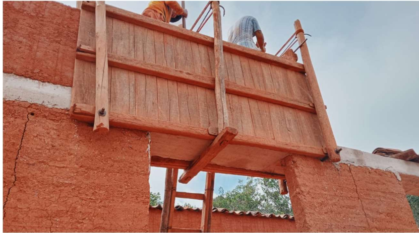
Ilustración 11. Taller práctico Construcción con Tierra (Tapia pisada)
