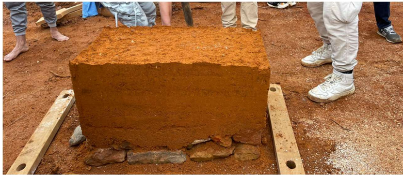
Ilustración 12. Muro tapia pisada con cimientos en piedra
