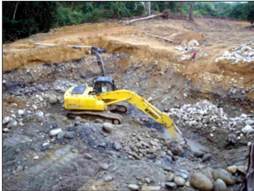
Fotografía 4. Retroexcavadora operando en La Toma. Fuente: Consejo comunitario La Toma 2014
