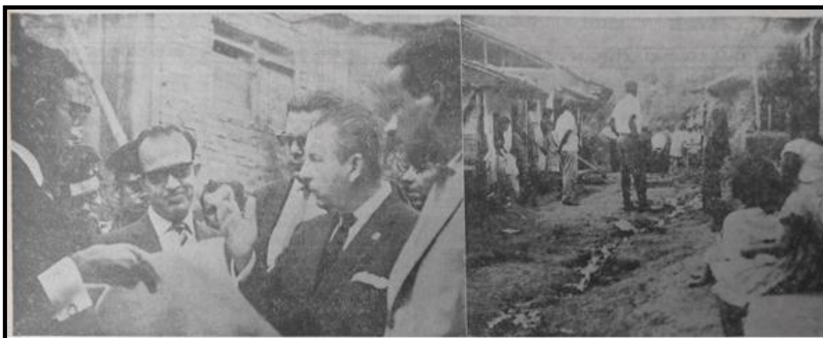
Foto 16. En el barrio Alberto Lleras Camargo fueron inauguradas importantes obras de alcantarillado, mediante actos especiales que se cumplieron el sábado último y a los que asistieron altos funcionarios y destacados elementos del Consejo, como de los organismos comunales. En la imagen izquierda aparece el señor Próspero Ramos, presidente de la junta comunal del sector, los doctores Gobert Pereira y Eduardo Buenaventura Lalinde, y los señores Saúl Catillo y Miguel Ángel Torres. Fuente: fotografía de El País (diario matinal conservador) 21 de noviembre 1966. No. 5.930. Año XVII.
