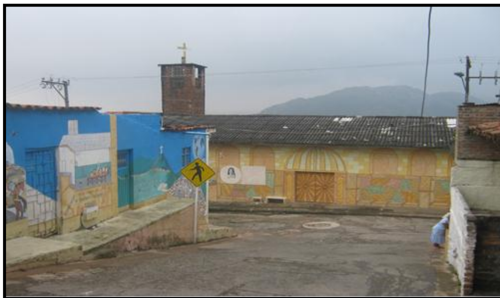
Foto 6. Estado actual de la capilla “San Ramón” del barrio Lleras Camargo. Fuente: imágenes tomadas por el tesista (2012).
