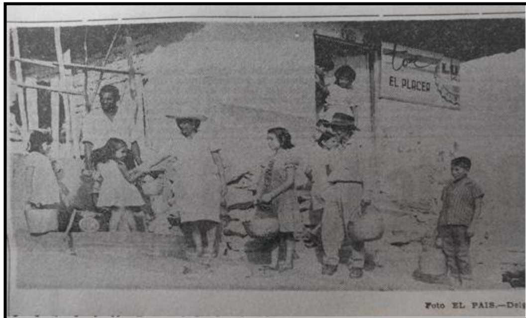
Foto. 14. Pilas construidas por las Empresas Municipales en el barrio Lleras Camargo. En la imagen se aprecian adultos y niños haciendo fila para llenar las ollas y recipientes que utilizan para cargar el agua hasta sus casas. Fuente: foto Delgado, El País. 10 de noviembre de 1966.
