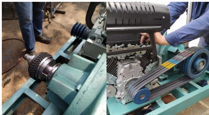
Figura 26. Montaje de sistema de transmisión de potencia
