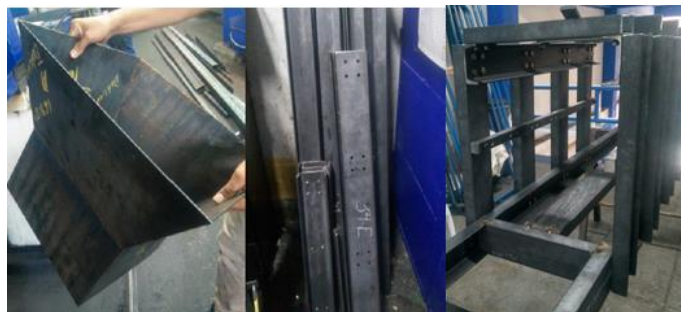
Figura 23. Construcción de tolva y cámara de compactación
