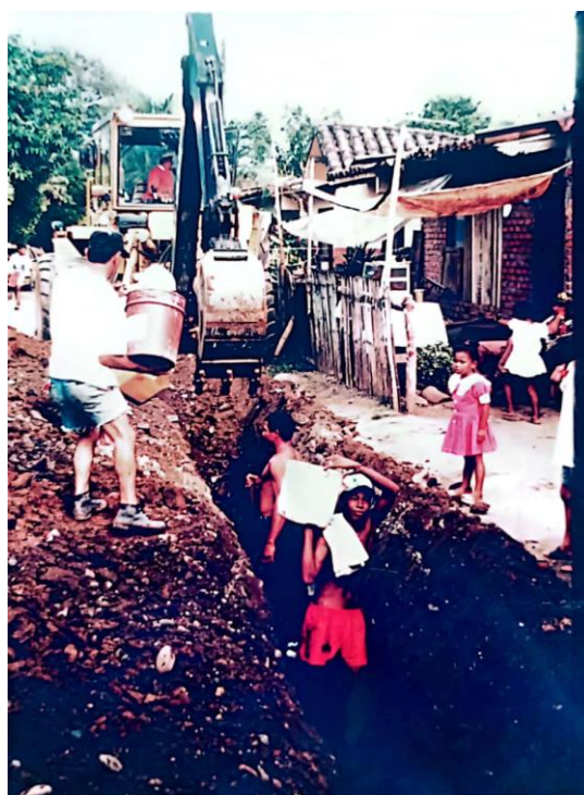
Construcción del primer acueducto comunitario, Álbum Fotográfico Consejo Comunitario Palenke.
