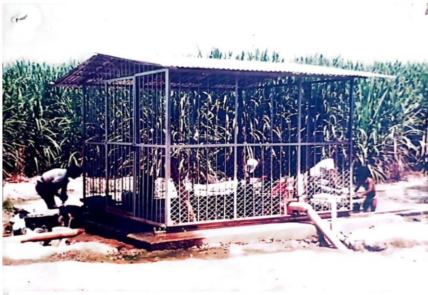
Instalación de Bomba de acueducto comunitario, Álbum Fotográfico Consejo Comunitario Palenke
