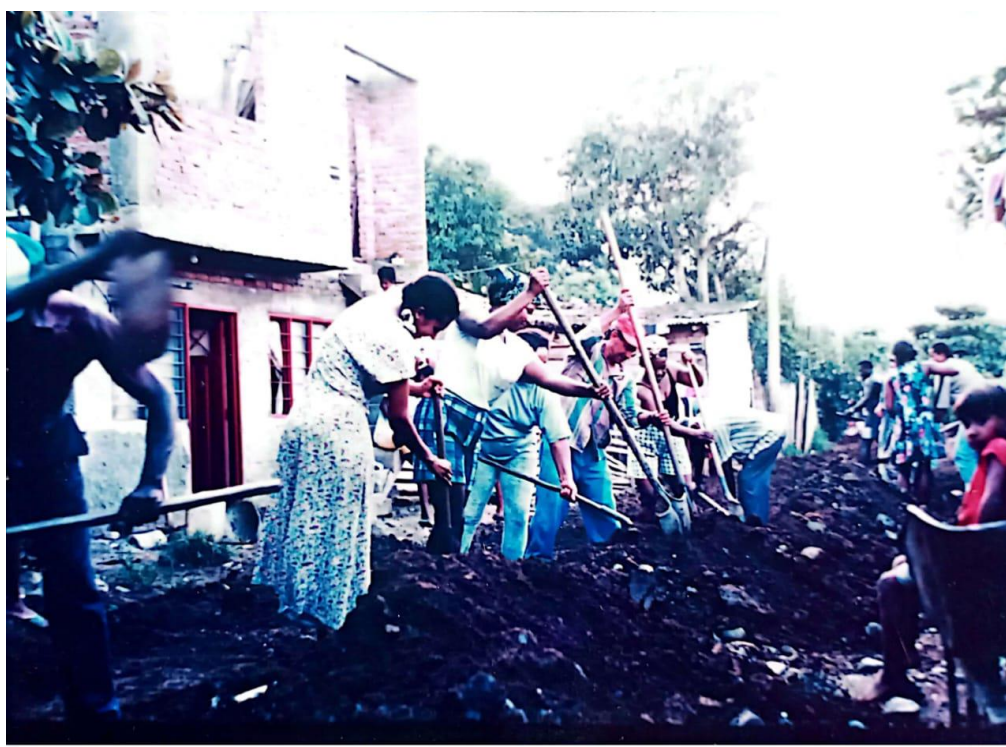
Construcción del primer acueducto comunitario, Álbum Fotográfico Consejo Comunitario Palenke.
