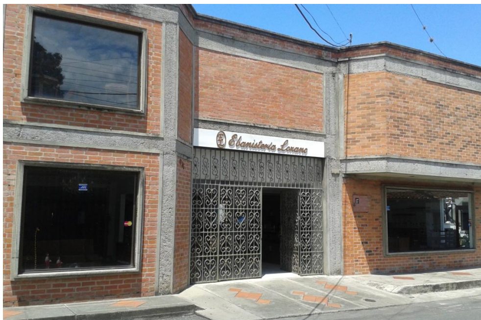
Figura 19. Fachada Ebanistería Lozano
