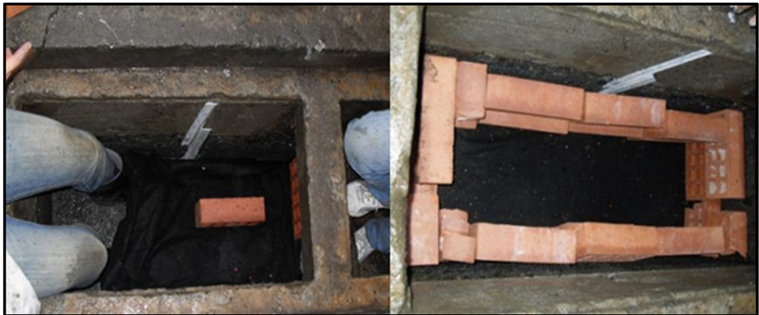
Figura A9. Colocación del geotextil y adecuación del compartimiento de la grava en el Sumidero M.
