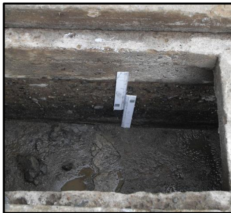
Figura A7. Instalación de reglas en los sumideros
