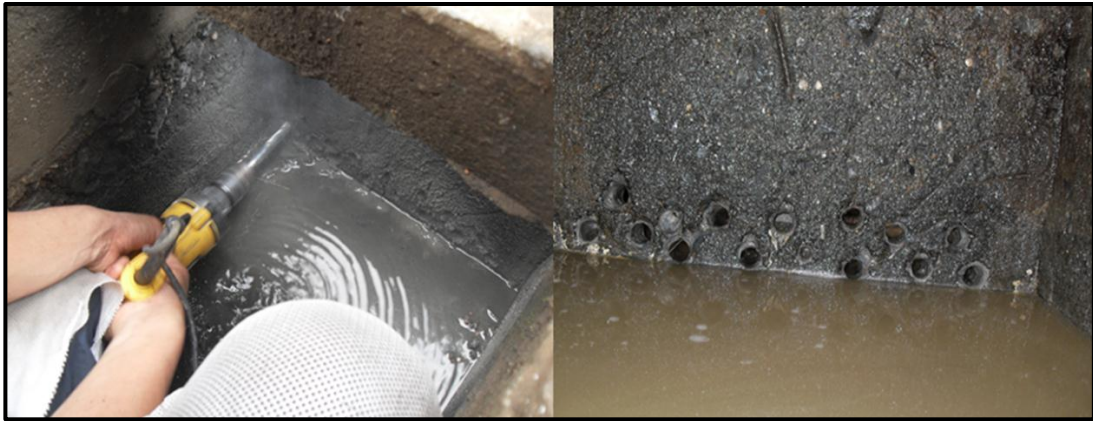
Figura A8. Perforación en el Sumidero M.
