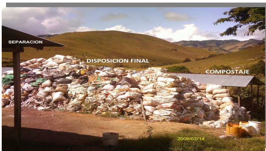
Figura 7. Identificación de las tres áreas principales de la planta de la zona rural; el primer techo es el final del área de separación y almacenamiento, seguido por el área de disposición final el cual se determina por la cantidad de residuos organizados en una pila grande casi de la misma altura de la primera área, y por último el área de tratamiento o compostaje.
