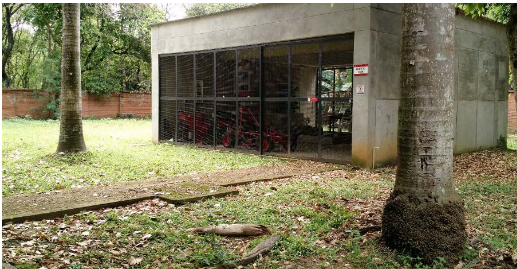
Figura 4-1 Edificio 344A del campus universitario Meléndez
