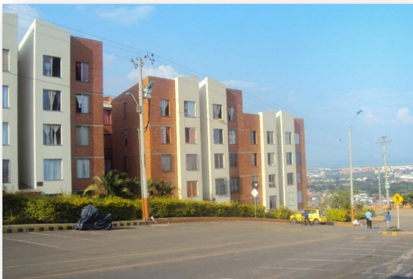
Foto No. 1: Altos de Santa Elena Fachadas Torre 1-3
