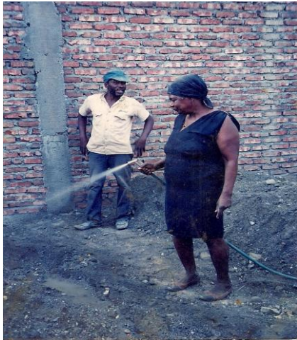
Abuela y su esposo en la construcción del piso de la sede.
