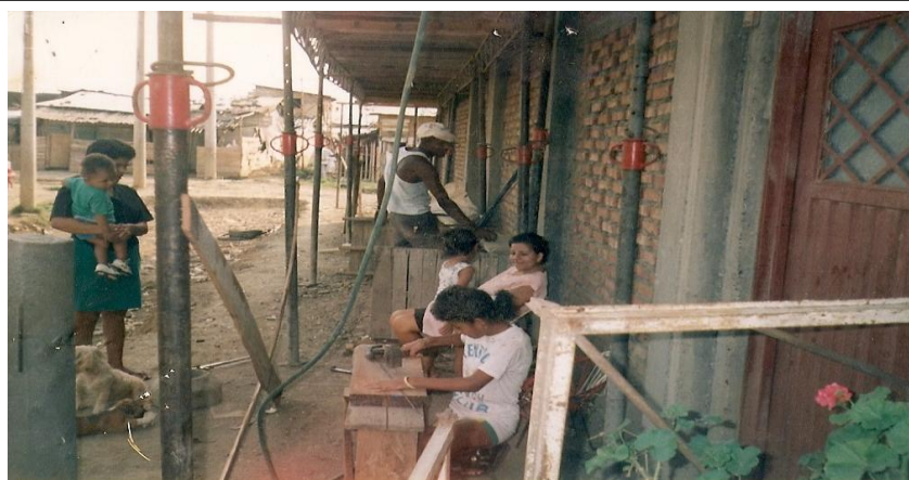
Carlos Yangana y una de sus hijas trabajando en la preparación de la construcción de la plancha de la sede.
