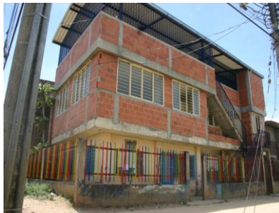
Sede de Arco Iris completamente terminada en sus 3 pisos.
