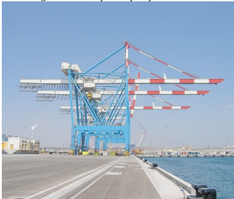
Figura 11 Grúas pórtico post panamax
