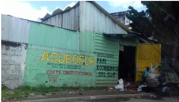
Figura 34. Bodega de ASOBOSUR Farallones
