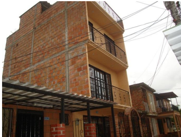
Foto 6. Unidad de vivienda en construccion de 3 pisos
