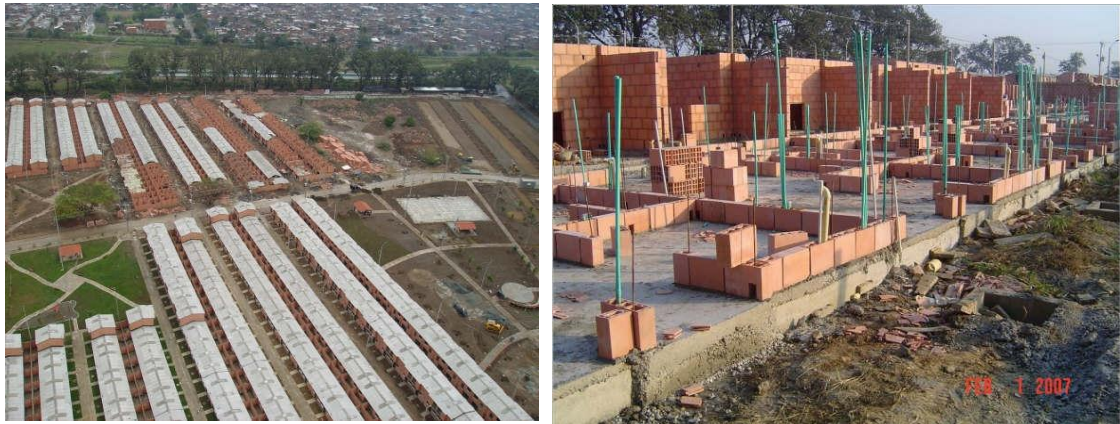
Foto 1. Urbanización Vallegrande etapa de la construcción del sector F
