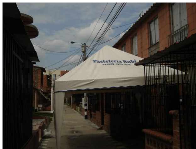
Foto 2. Cubierta de tela que sobresale hasta el andén de las viviendas
