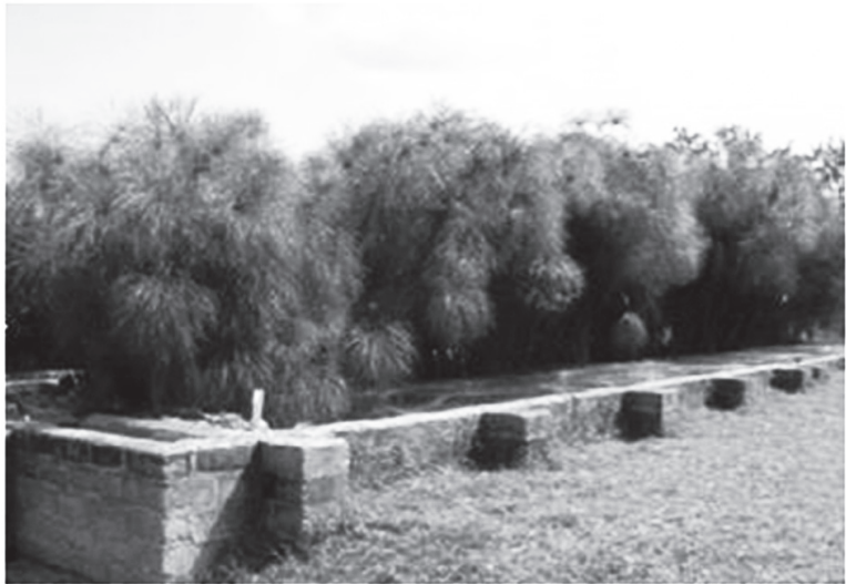
Fotografía 8. Humedal para el tratamiento de aguas residuales
