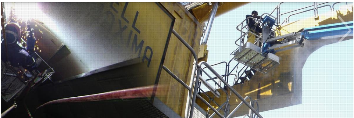
Figura 4. Mantenimiento de estructuras metálicas
