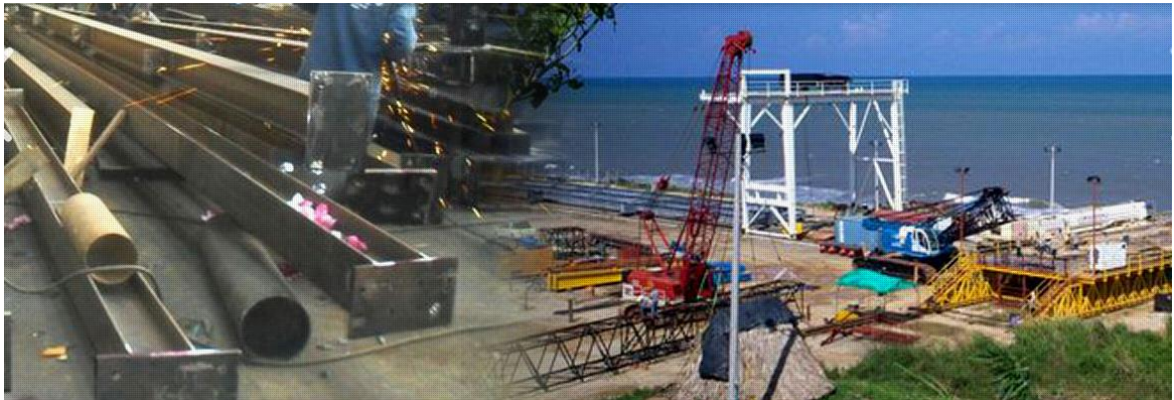
Figura 11. Interventorías y consultorías en estructuras metálicas
